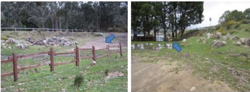
Figura 8: Infraestructura sector faja vial ocupada como estacionamiento
