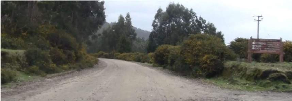
Figura 10: Ruta T-50, a 30 m del puente Chaihuín
